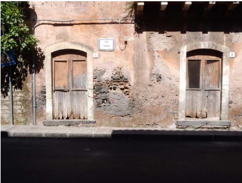
Fig. 1. Architettura storica su via Roma (San Giovanni La Punta - CT): sistemi costruttivi e materiali locali che testimoniano un modus costruendi strettamente connesso alle risorse dell'areale etneo (foto Sanfilippo).
